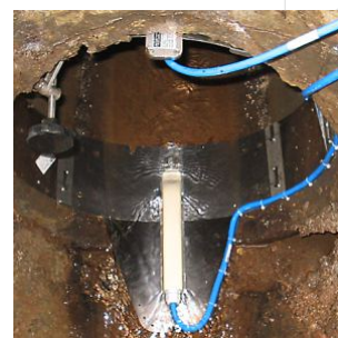
Măsurarea aer-ultrasunete, apă-ultrasunete și hidrostatică - pentru detectarea întregului interval de refulare de ex. pentru determinarea eficienței canalului
