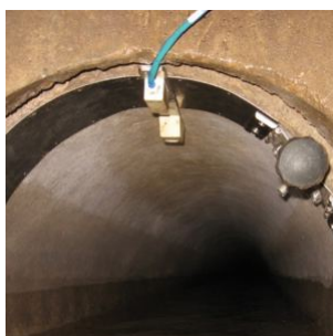
Senzor aer-ultrasunete - pentru detectare de niveluri scăzute De ex. detectarea apei din exterior.
