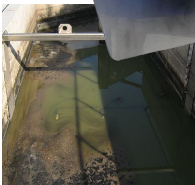
Mecanism de ridicare în scopul de verificare sau de înlocuire a senzorului
