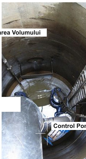
Măsurarea Bazinelor De Retenție Cu Deversare
