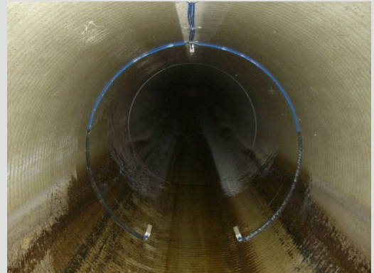
Punctul de măsurare din canal
