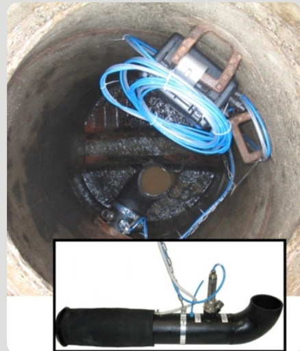
Punctul de măsurare din canal
