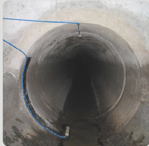
Punctul de măsurare în canal
